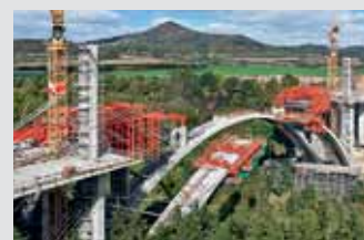
Encofrados para puentes
