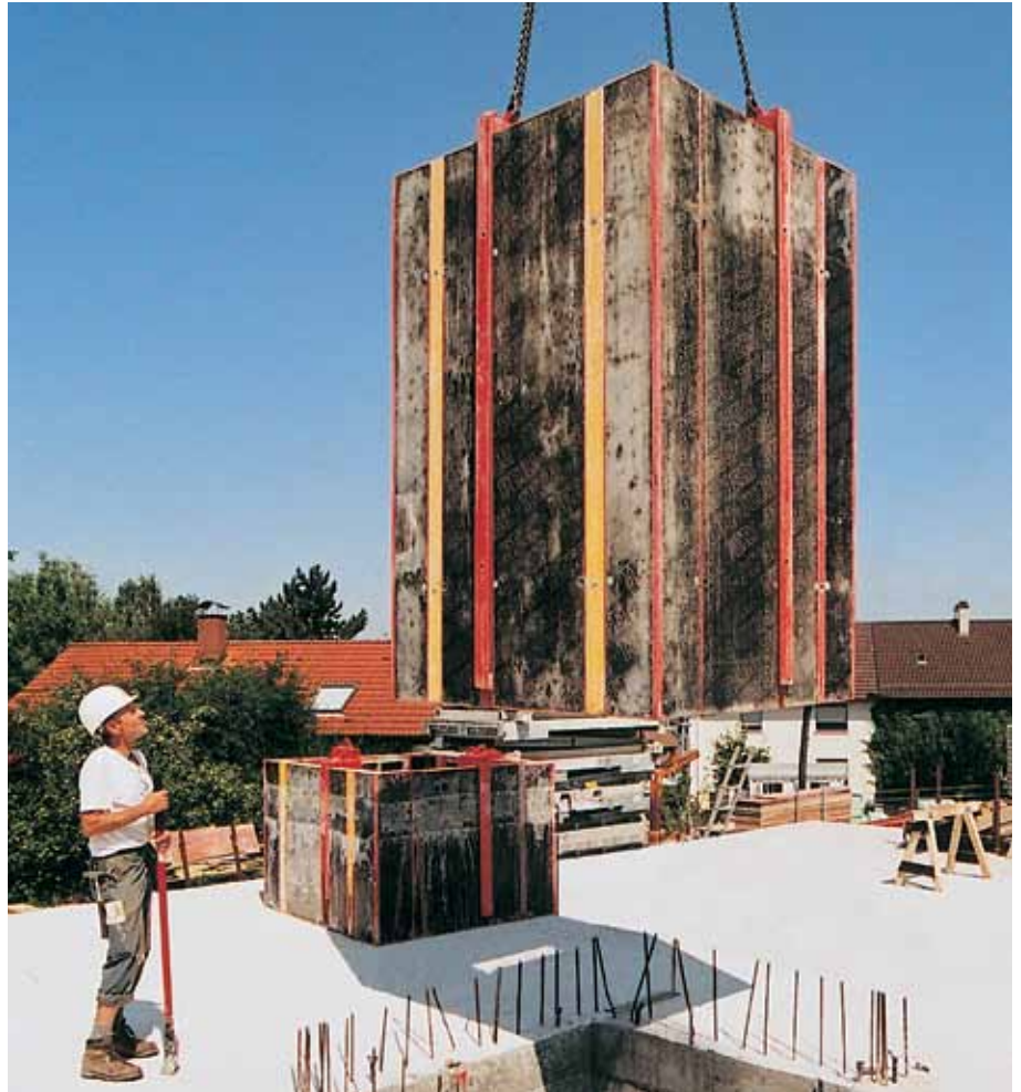
El encofrado para huecos y núcleos completo colgado de la grúa.
