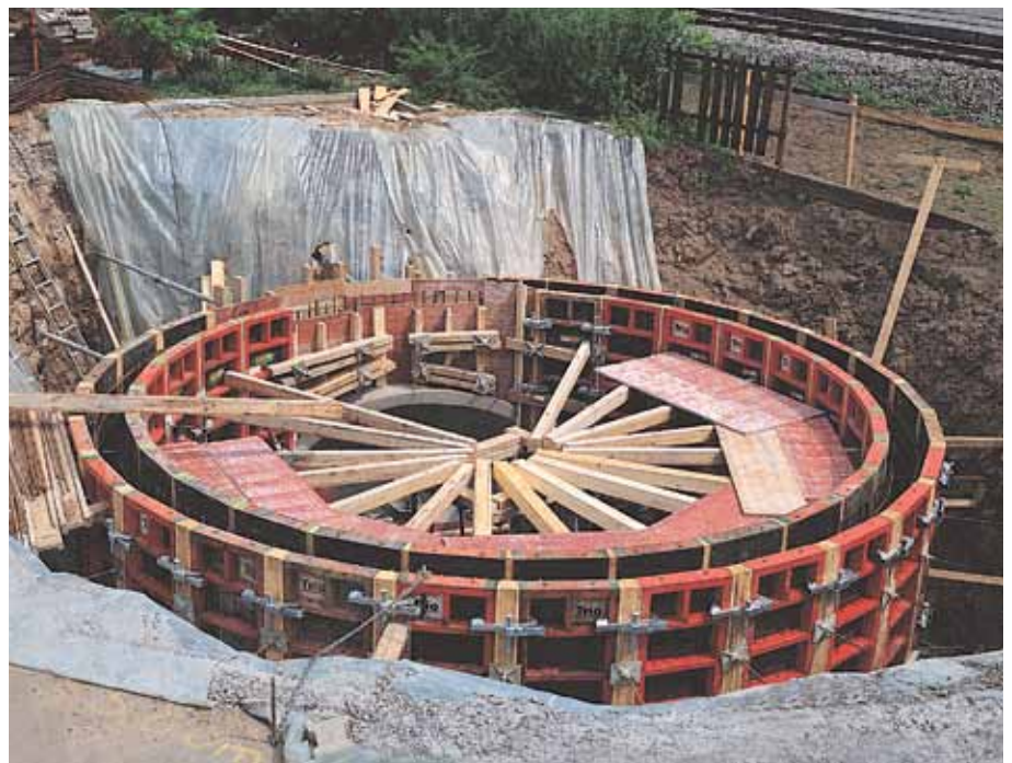
Obra de canal, encofrado con paneles TRIO TR 270 x 60.
