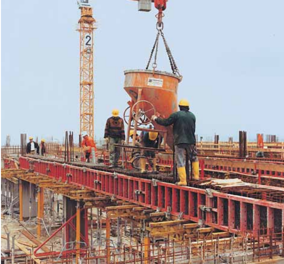
Vigas de cuelgue pequeñas con TRIO apuntalamiento con puntales MULTIPROP
