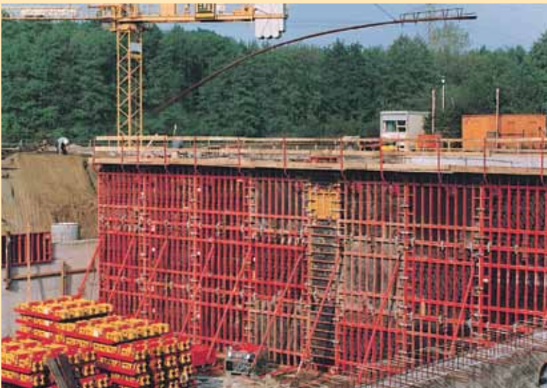
Planta de tratamiento
