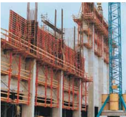
TRIO sobre encofrado trepante
