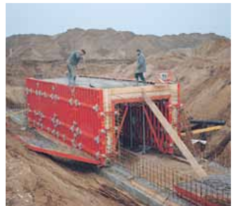
Túnel de sección rectangular con piezas TRIO estándar
