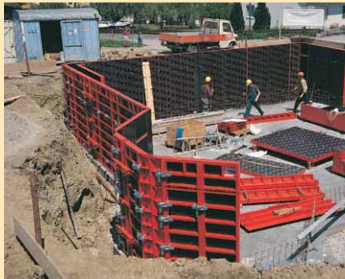
Construcción de viviendas
