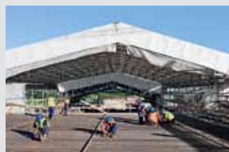
Andamios de protección
