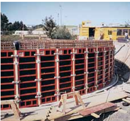
Paneles estándar para construcciones circulares
