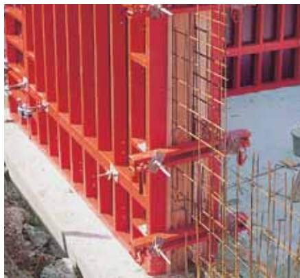
Con punto de atado interno (en panel grande 270 x 240 o panel multifunción TRM 72).
