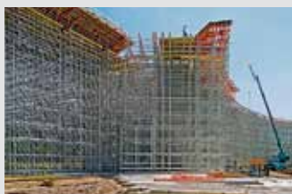
Cimbras y torres de carga
