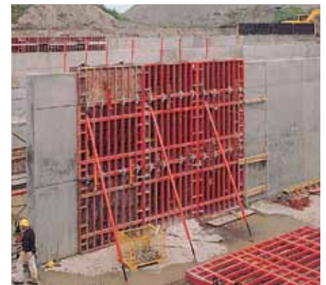
Paneles TRIO en sentido horizontal, superpuestos hasta una altura de 6,0 m.
