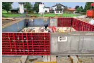
Encofrados para muros
