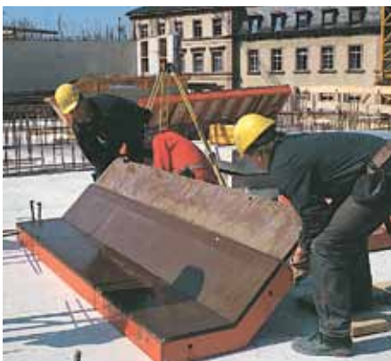
Paneles de esquina 135° cubiertos con un gran tablero de encofrado, para la construcción de un hotel.
