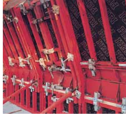
TRIO para techos inclinados El ángulo para el quiebre se logró con esquina articulada y correa especial. Los esfuerzos verticales se descargan a través de correas y estabilizadores.
