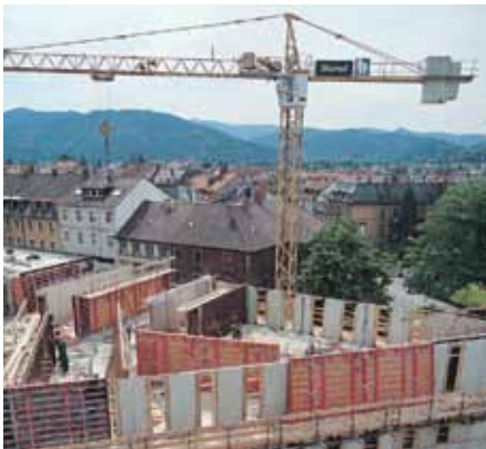
Unidades de paneles de hasta 9 m de ancho y 2,70 m de alto cubiertos con tableros de grandes dimensiones.
