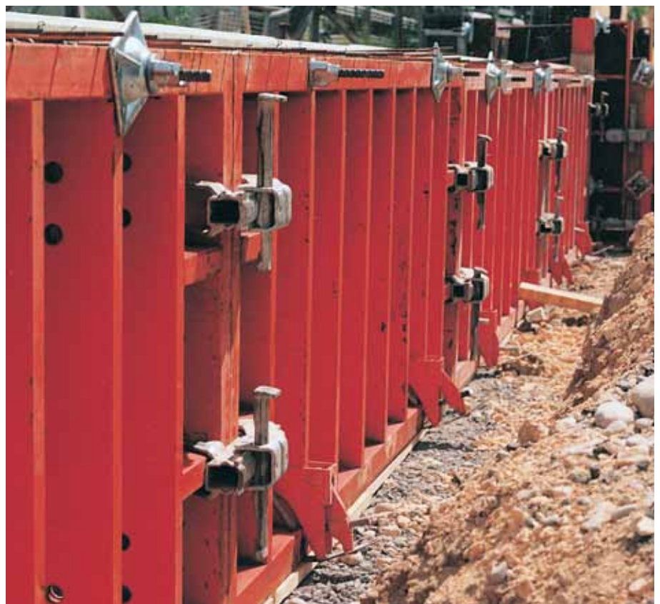
Cimiento de una nave de fábrica encofrado con tensor de cinta perforada.
