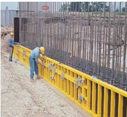
El TRIO-L para encofrar cimientos.
