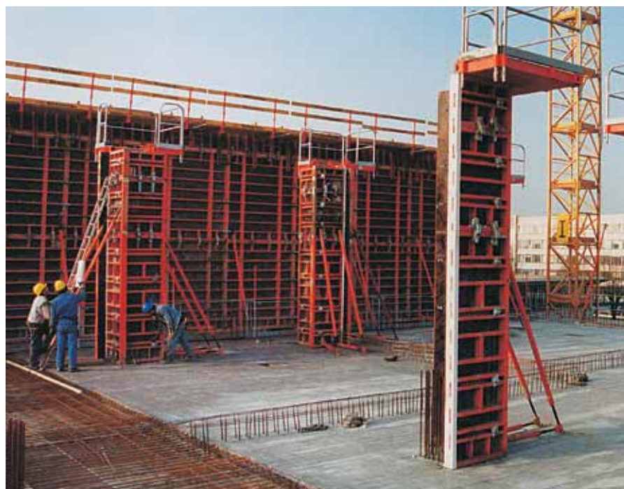
Paneles de encofrado para pilares TRIO unidos hasta 4,50 m de altura con plataforma de hormigonado.
