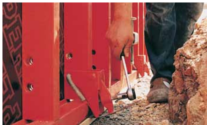
Cimiento de una nave de fábrica encofrado con tensor de cinta perforada.
