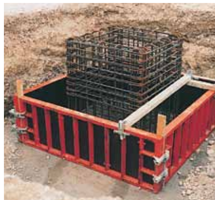
Para la ejecución de cimientos los paneles se utilizan en sentido horizontal.
