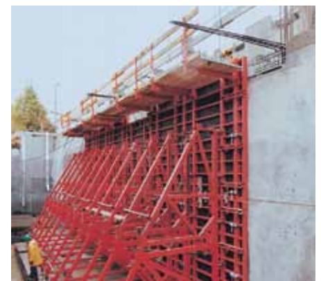
Encofrado a una cara
