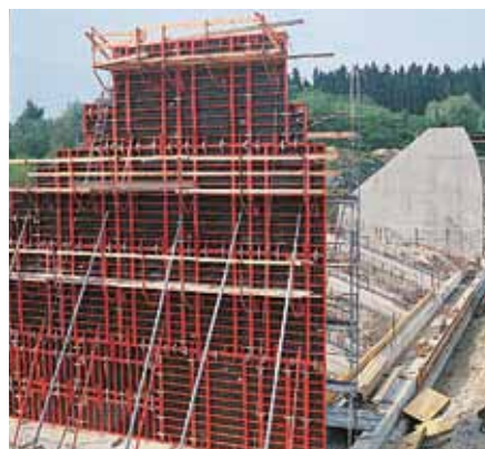
Muro de 13,20 m de alto
