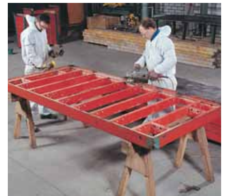
Con el servicio de reparación y mantenimiento.
