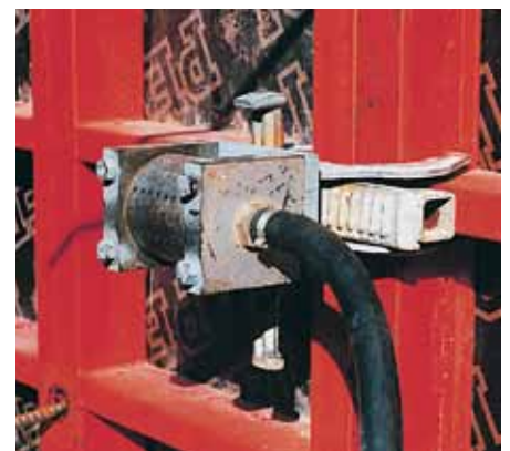
Conexión de vibradores exteriores
