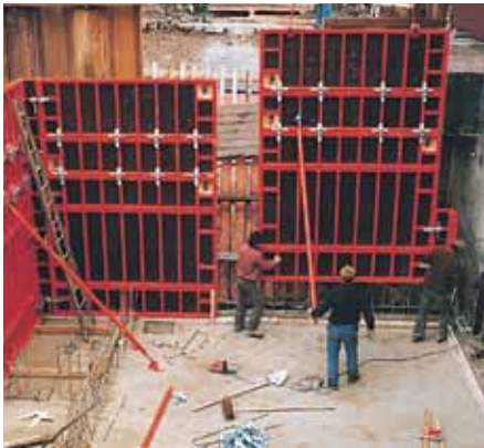
Unión en altura sin paneles especiales.
