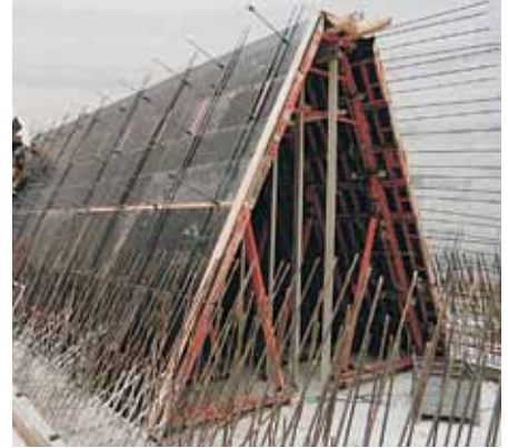
Túnel trapezoidal con TRIO y escuadra SKS
