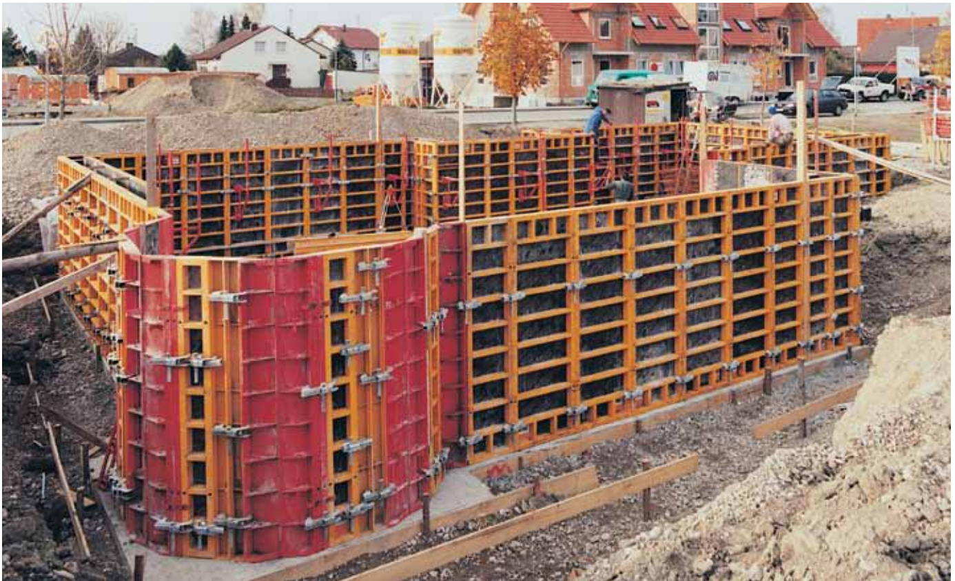
Los paneles TRIO-L están disponibles en cuatro anchos y dos alturas, 270 cm y 90 cm.
