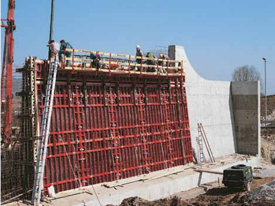
Muros de contención
