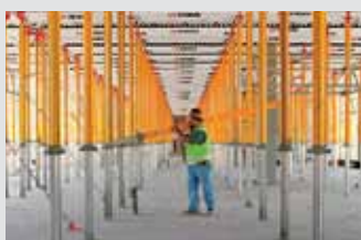
Encofrados para losas
