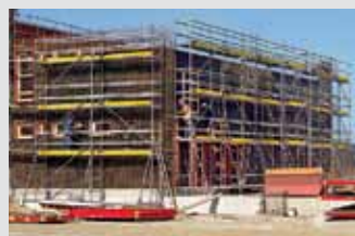
Andamios de trabajo para la construcción
