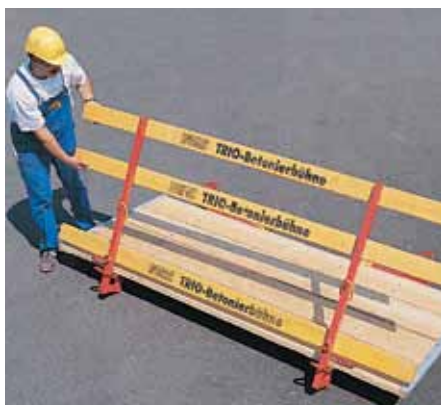
Abatir la barandilla de la plataforma y asegurar con bulón incorporado.
