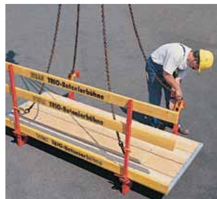
Colgar la plataforma de hormigonado del aparejo de 4 eslingas. Los 4 puntos de izado están identificados en amarillo.
