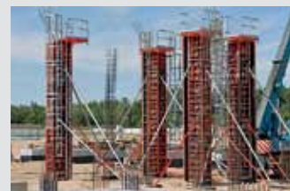
Encofrados para pilares y columnas circulares
