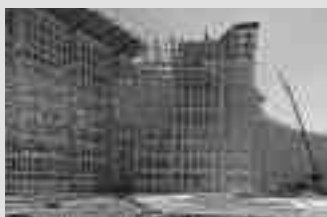
Cimbras y torres de carga
