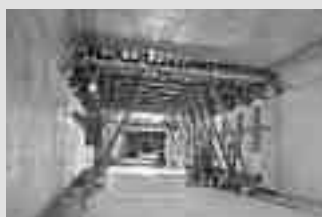
Encofrados para túneles
