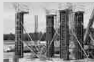
Encofrados para pilares y columnas circulares
