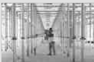
Encofrados para losas
