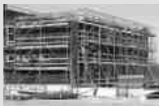
Andamios de trabajo para la construcción
