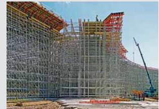
Cimbras y torres de carga
