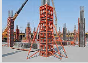
Encofrados para pilares y columnas circulares
