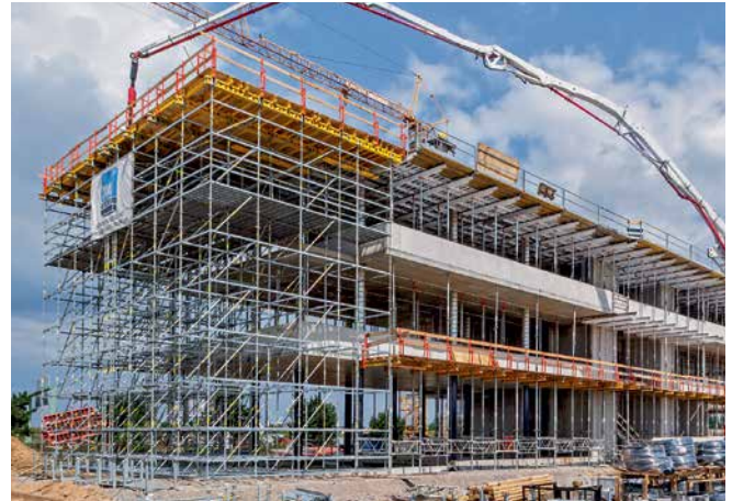
Solución completa de un mismo proveedor: los encofrados para muros y losas, así como los andamios de carga y para colocar armadura se ajustaban de modo óptimo a los requerimientos del proyecto.
