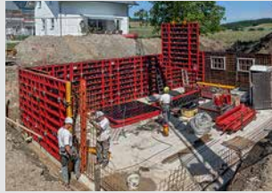
Encofrados para muros
