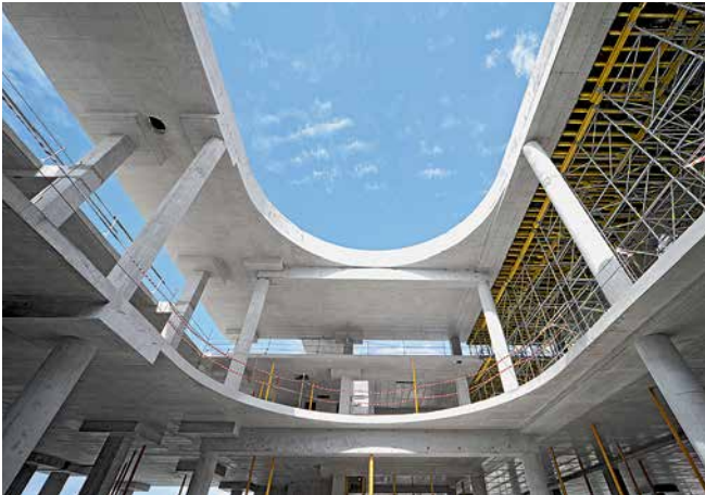
Las losas de hormigón armado de 30 cm de espesor se encofraron con MULTIFLEX.
