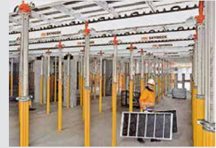
Encofrados para losas
