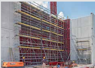
Andamios de trabajo para la construcción
