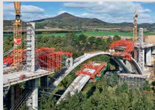
Encofrados para puentes
