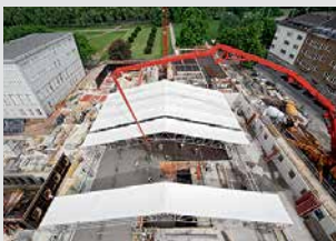
Andamios de protección
