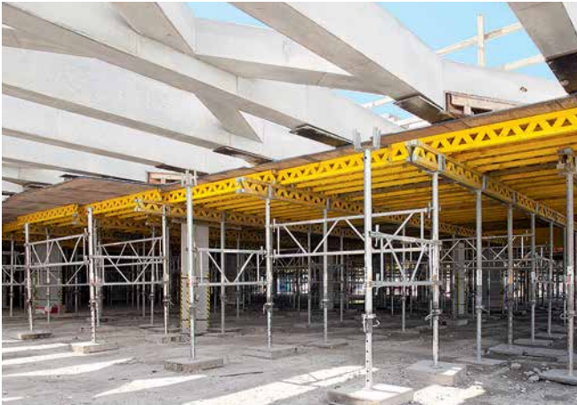
MULTIFLEX se utilizó para ejecutar las vigas de cuelgue en hormigón in situ, los puntales PEP estaban unidos con bastidores PRK formando torres de carga.
