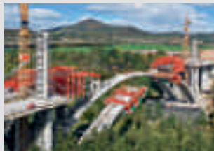
Encofrados para puentes
