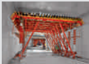
Encofrados para túneles
