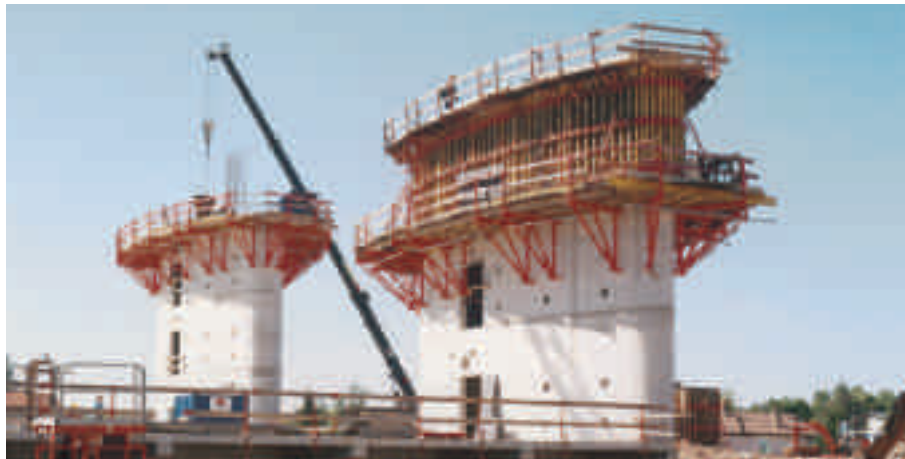
Edificios culturales Hormigón visto de excelente acabado con consolas CB 240 y VARIO GT 24.
