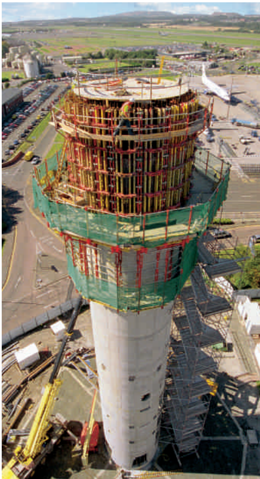
Torre de control de aeropuerto 46 m de alto, Ø 6,85 m exterior. Con PERI RUNDFLEX y consolas CB 240.
