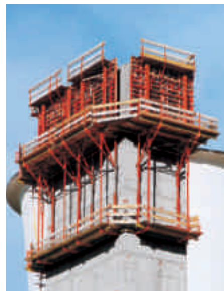
Edificio de oficinas CB 240 con plataformas de terminación y TRIO.
