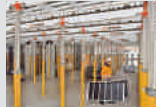
Encofrados para losas
