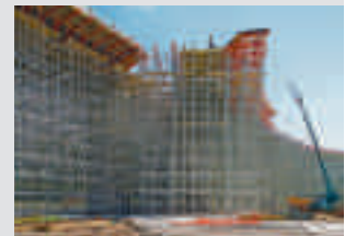
Cimbras y torres de carga
