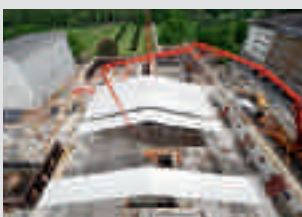
Andamios de protección
