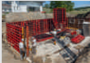
Encofrados para muros
