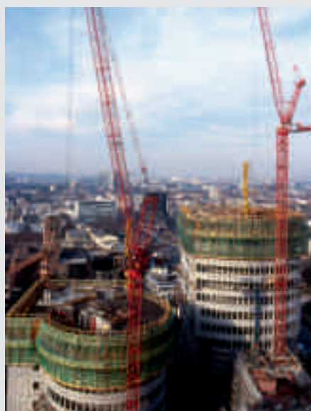
Edificio administrativo CB 240 con TRIO y VARIO GT 24.
