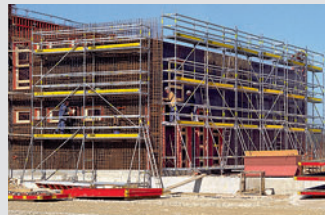
Andamios de trabajo para la construcción
