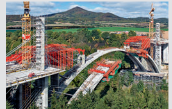
Encofrados para puentes
