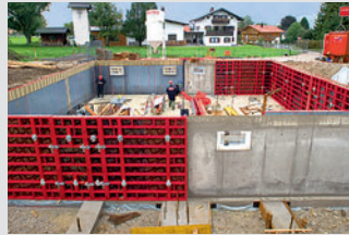
Encofrados para muros
