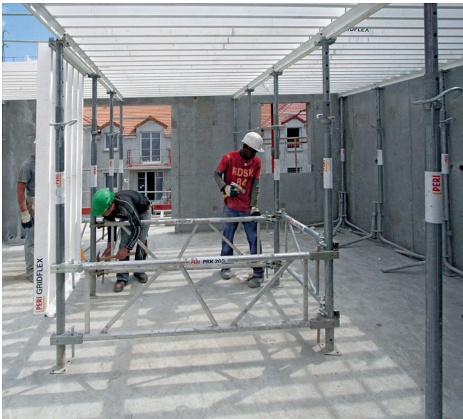
El trípode PEP Ergo y los bastidores PEP PRK se utilizan como elementos auxiliares de montaje.
