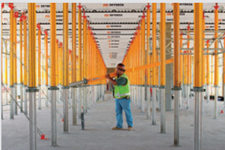
Encofrados para losas
