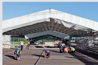
Andamios de protección
