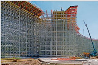
Cimbras y torres de carga
