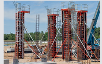
Encofrados para pilares y columnas circulares
